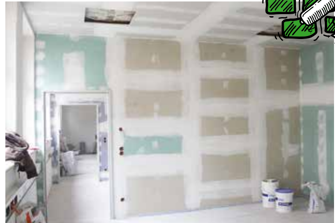
Neue Büro- und Beratungsräume entstehen.
