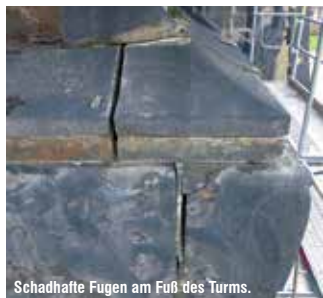
Schadhafte Fugen am Fuß des Turms.
