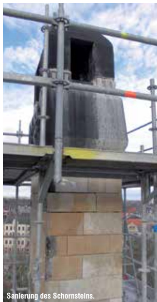
Sanierung des Schornsteins.
